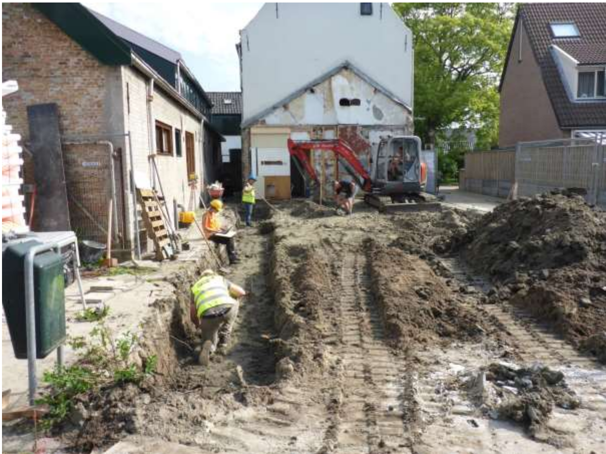
Figuur 4. Impressie van de werkzaamheden en het onderzoek.
