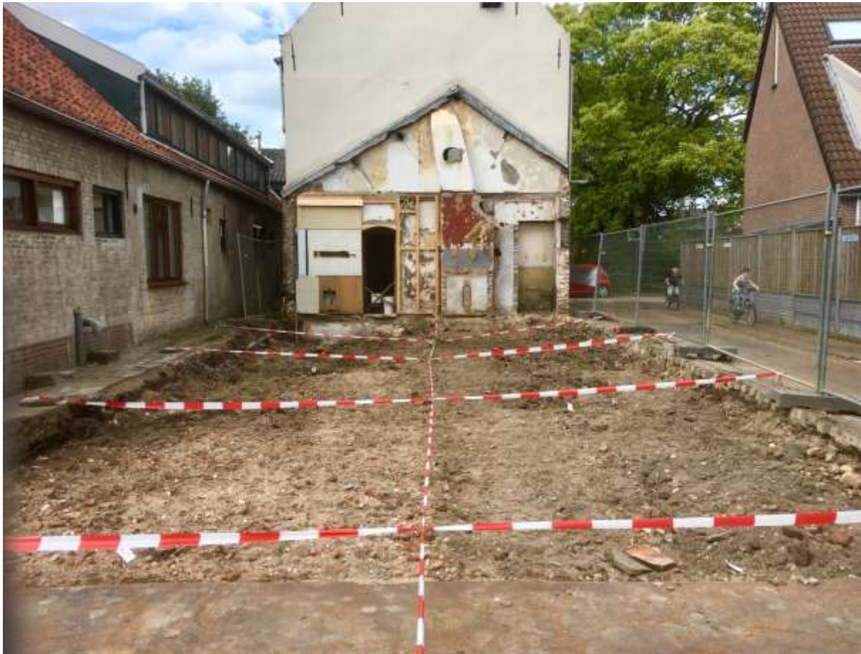
Figuur 3. Overzicht van het plangebied na de sloop van de bovenbouw en vloer en van de vakverdeling uit het onderzoek door de HG-HIA en AWN (foto: N. Klaus, AWN Lek- en Merwestreek).
